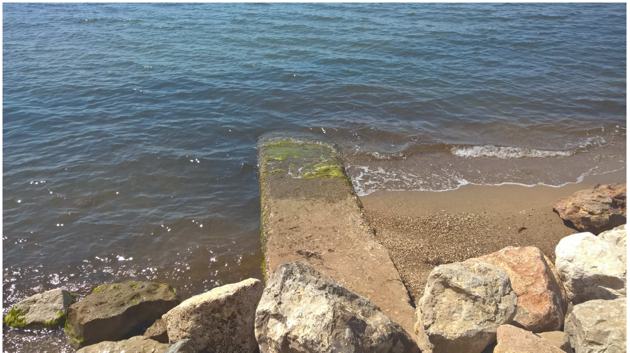
Figure 2-12 : Accumulation de sable devant les enrochements du secteur DCNS, côté Ouest d'un des petits épis béton (photo B. Waeles lors de la visite technique du 15/06/2017).
